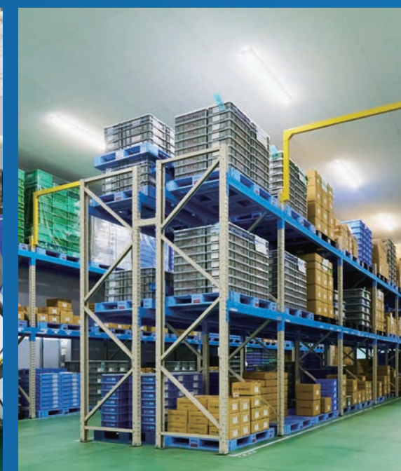
完成品倉庫(耐震対策済)
